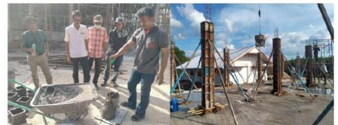
ปลัดเทศบาล คณะกรรมการพร้อมช่างควบคุมงานตรวจเสาะอาคารชั้น 2 โครงการก่อสร้างอาคารสำนักงานเทศบาลตำบลเวียงบึงบอน
