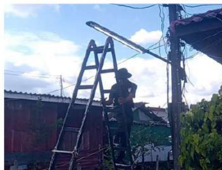
กองช่างลงพื้นที่ให้ความ อนุเคราะห์ติดตั้งเสาไฟ ชุมชนบ่อหลวง
