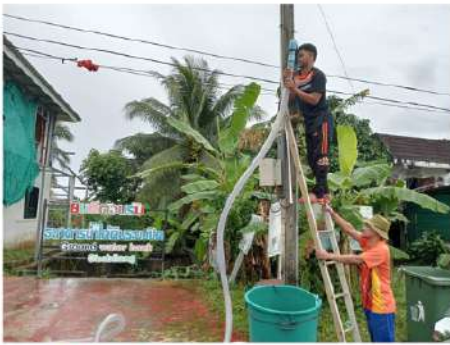
งานป้องกันฯ ดำเนินการเปลี่ยนสายยางใหม่ ณ จุดรับน้ำ ชุมชนบ่อหลวง
